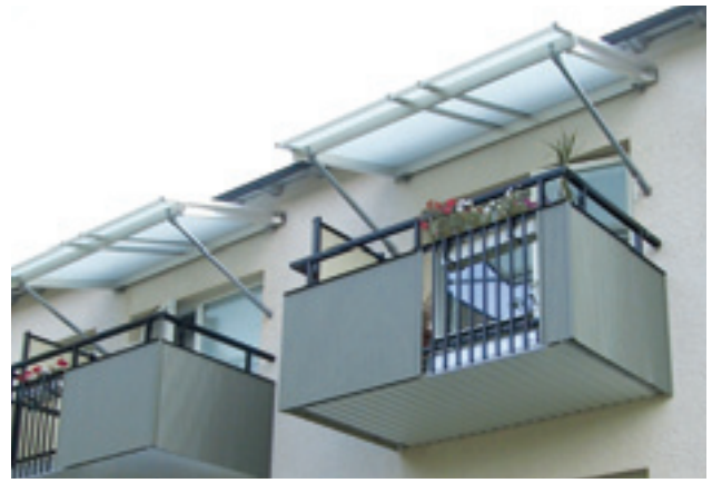
Skärmtak av kanalplast.
